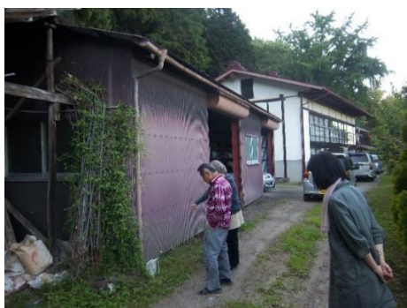
Zone d'accumulation au pied de gouttières (Japon, Oguni city, CRIIRAD, 2012)
