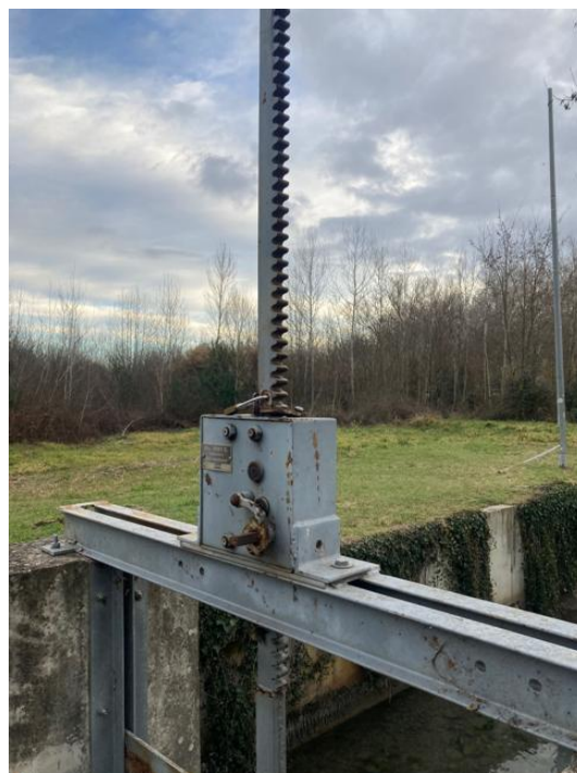
Photos 6 : la vanne droite
