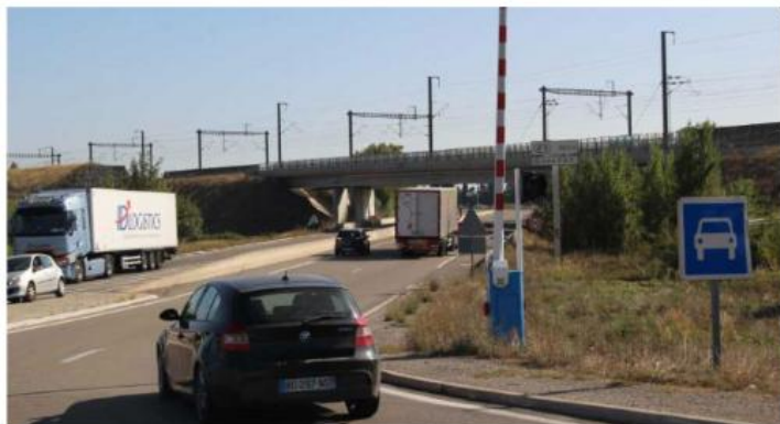
La tranche 1 de la LEO, entre Courtine et Rognonas, est aujourd'hui sous-utilisée. PHOTO ARCHIVES F.C.
