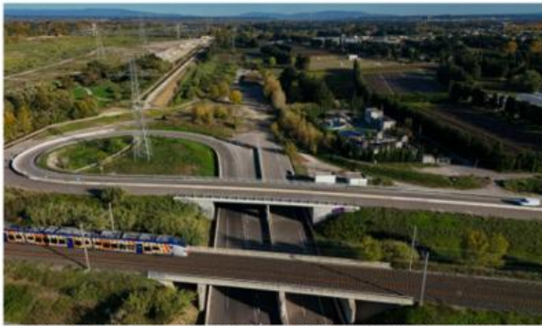
Depuis quinze ans, la tranche 1 de la LEO finit en voie de garage, au niveau de l'échangeur de Rognonas, attendant patiemment son prolongement vers le rond-point de l'Amandier. / PHOTO JÉRÔME REY
