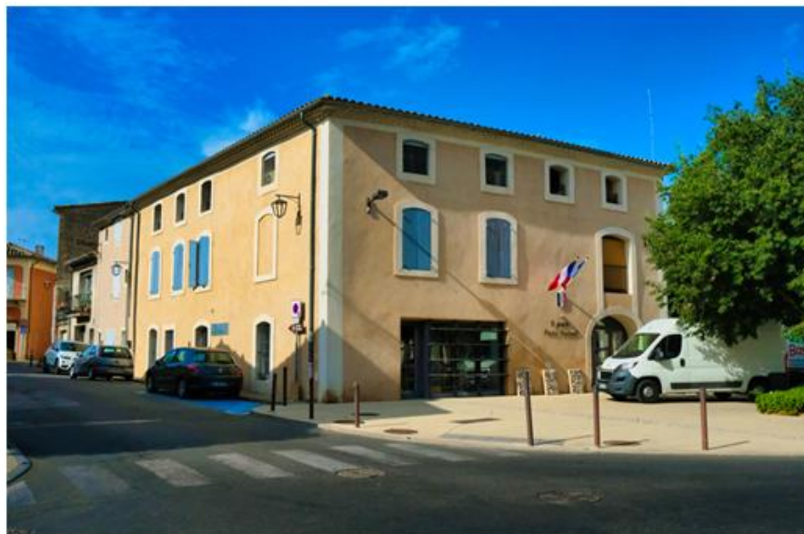
A Caumont-sur-Durance, l'ancien bar de cœur de ville accueille 8 logements et une bibliothèque municipale. © EB
