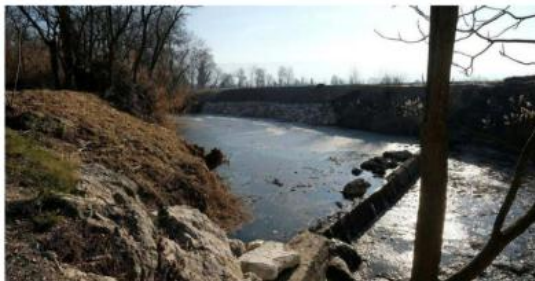
Les travaux de confortement des berges du Coulon, ici au niveau du seuil de Fuguiérolle.
