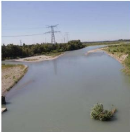
EDF mènera une opération d'essartement sur plusieurs kilomètres de la Basse Durance. / PHOTO G.R.
