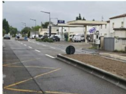
Les services techniques sont intervenus sur les terre-pleins centraux de l'avenue du Maréchal-Leclerc. / PHOTO DR
